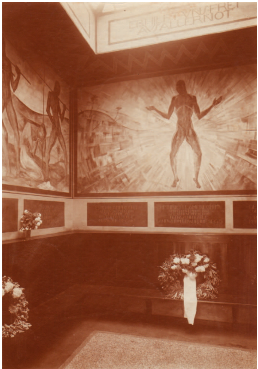
Abb. 5: Der Innenraum der Gedenkhalle nach ihrer Fertigstellung 1921. Von links überdeck die Gedenktafeln an Otto Kay, Erich und Heinrich Lamprecht. [Museum Vietze]
