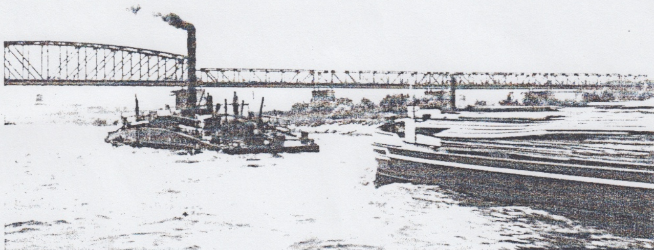
Bild 5.4. Kettendampfer „NNVE 9“ unterhalb der Herrenkrug-Eisenbahnbrücke bei Magdeburg, der Anhang folgt in kurzem Abstand; um 1935
