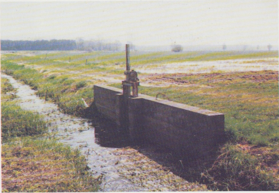
Abbildung 33: Staubauwerk in der Gemarkung Pevestorf am Elbholz, Mai 1979
