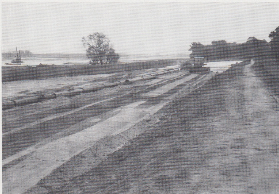
Abbildung 16: Spülarbeiten in der Gemarkung Pevestorf (Neubrack) Elbe-km 482,5; im September 1982
