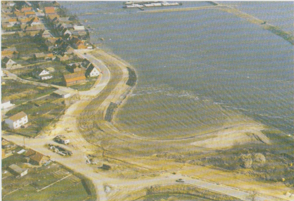
Abbildung 22: Alanddeich im Rohbau, März 1981
