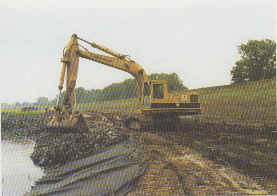
Abbildung 26: Ufersicherungsarbeiten an der Schardeichstrecke Holtorfer Steege, August 1985
