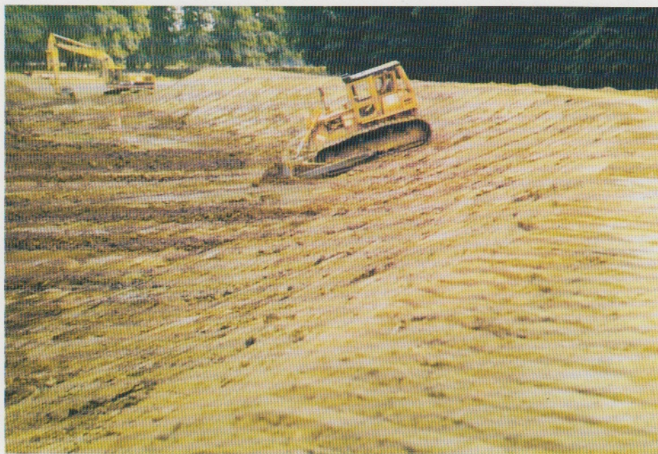
Abbildung 23: Deichbau im Elbholz (Elbe-km 481,4), Juli 1982
