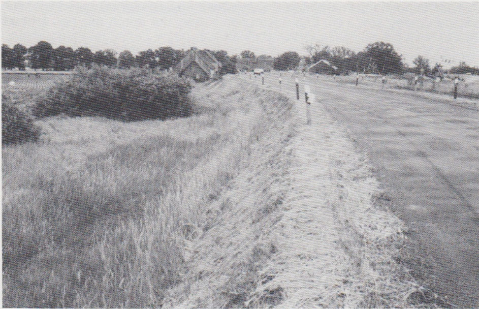
Abbildung 19: Rechtsseitiger Seegerückstaudeich bei Quarnstedt. Binnenböschung vor dem Ausbau, Juni 1976
