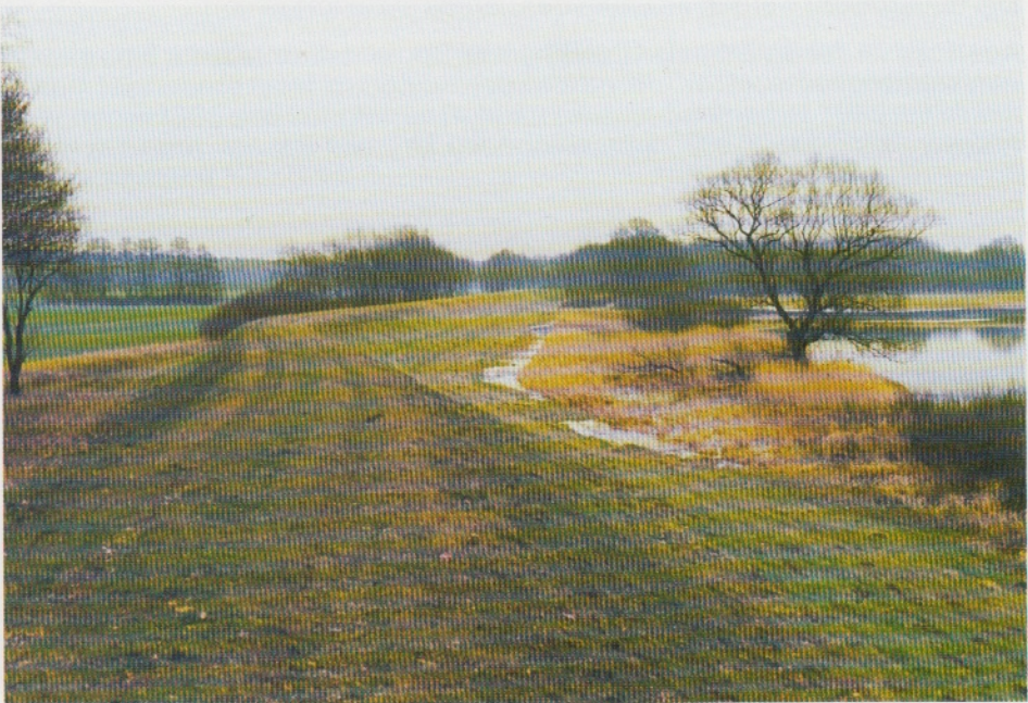
Abbildung 28: Seegerückstaudeich oberhalb vom Gut Quarnstedt vor dem Ausbau, Zustand Februar 1985
