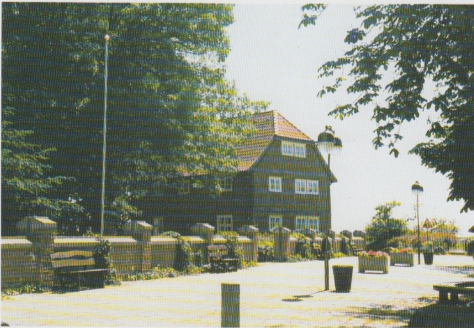
Abbildung 21: Binnenseitige Ansicht der Hochwasserschutzmauer in Schnackenburg, April 1986
