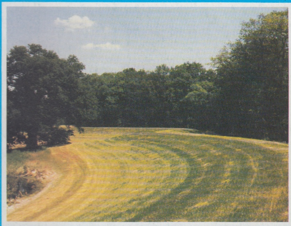
Ausgebauter Deich am Stollenbrack im Elbholz, Juli 1986
